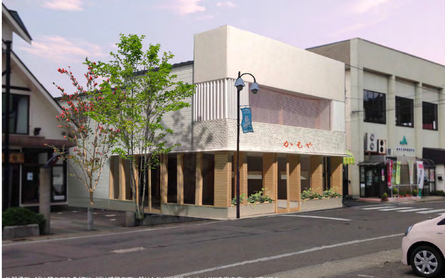
外観模型 1Fは開口部を多く取り、2Fは道路側窓に設けた外付けブラインドにより光を室内奥まで取り込む
